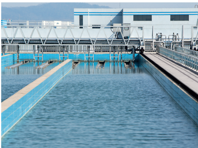
饮用水絮凝池
